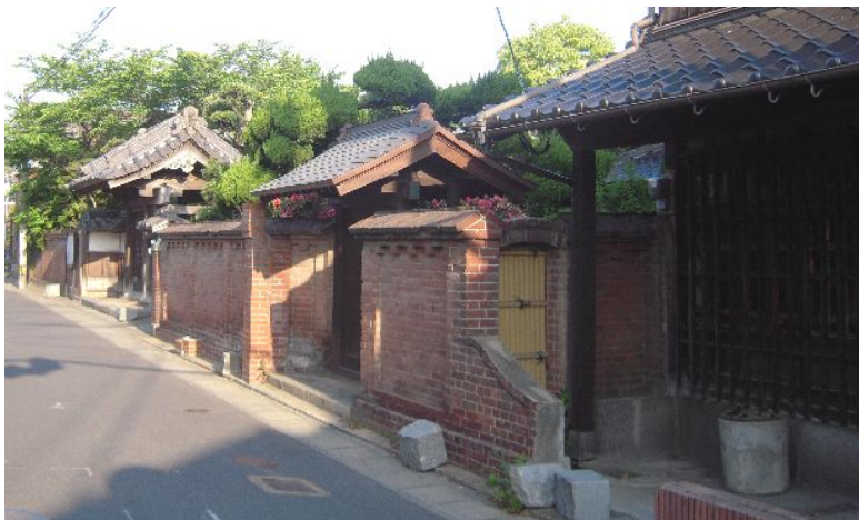
<近世の中津街道（行橋市）>
